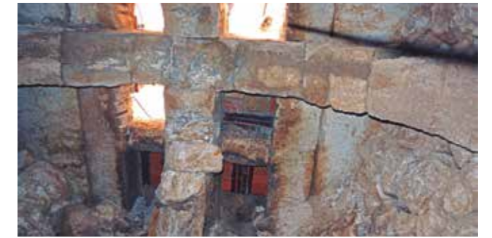
Arcos de la bóveda con la que se haya cubierto el pozo. Vista interior.
