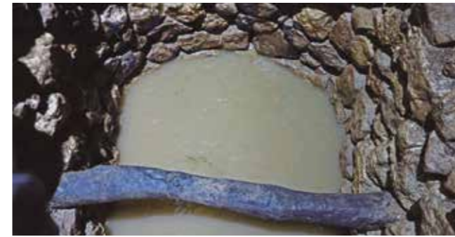
Imagen del basamento del pozo, tras la limpieza.
